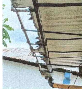
Foto 2: Se evidencia el deterioro de los canes a sustituir.
